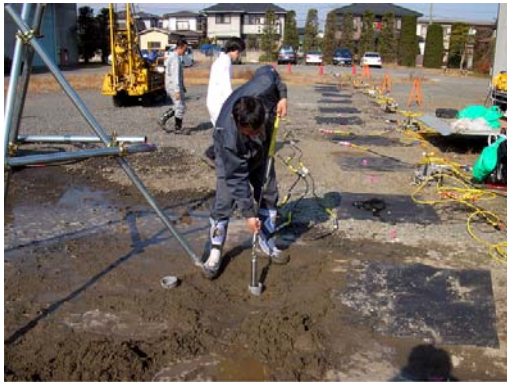
掘削・ケーシング(100mm、塩ビ)後のVSPソンの挿入
