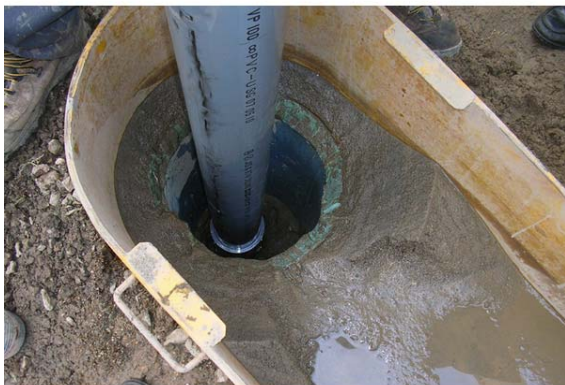
3成分MEMS地震計設置用140mm塩ビ管の挿入の場合、底部にキー溝付き土台あり
